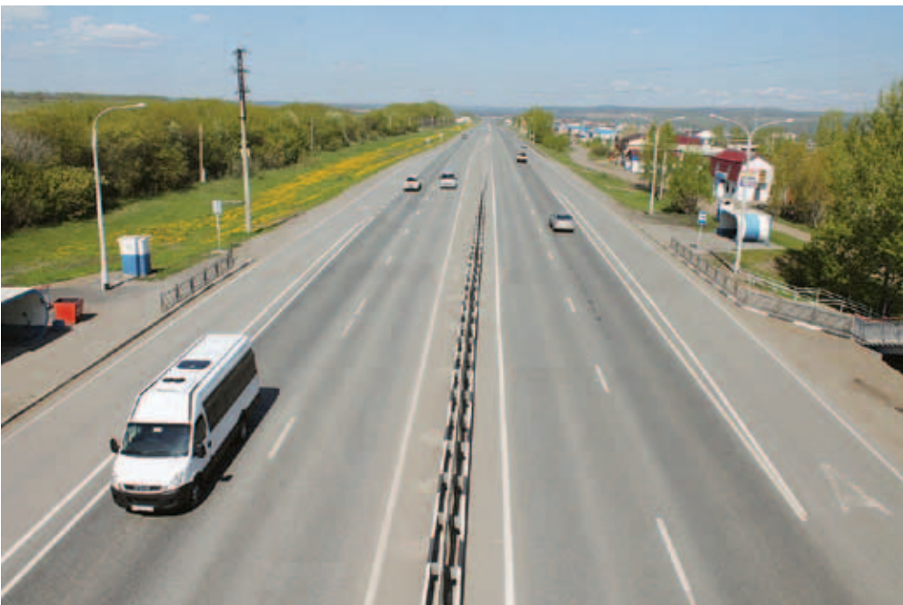
КрайДЭО обслуживает более 9 тыс. км. автодорог
