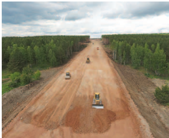
Р-255, строительство обхода г. Канск
