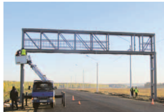
Монтаж П-образной опоры для оборудования
