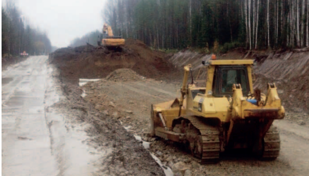
Ремонт автодороги Епишино – Северо-Енисейский
