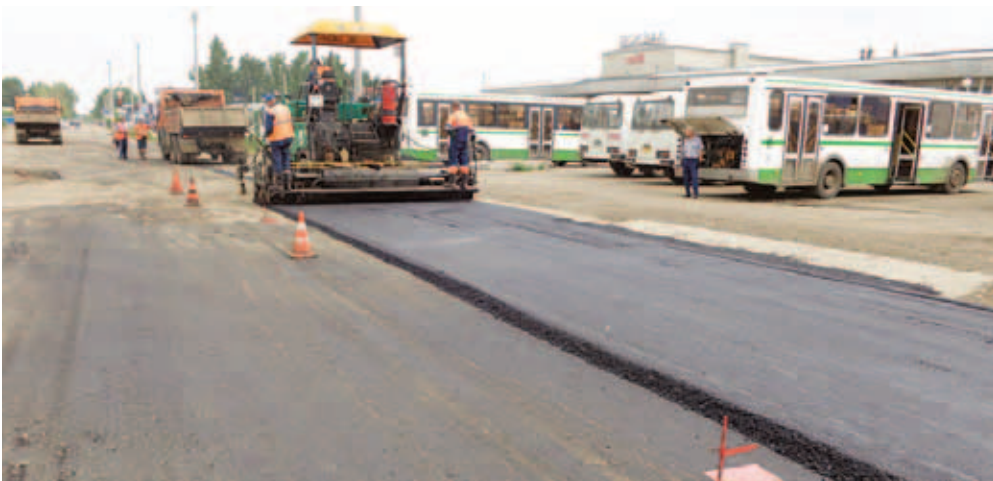
Запланированный объем работ по ремонту улично-дорожной сети выполнен
