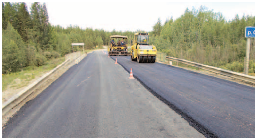
Ремонт дорожного покрытия, мост через р. Сыромолотово
