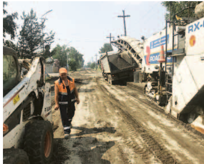
Ремонт ул. Ленина, г. Енисейск
