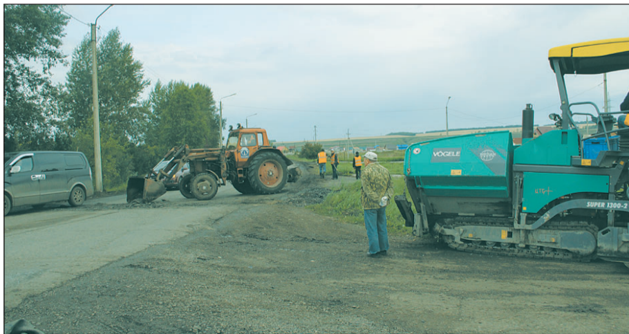
Ремонт улицы Московской поселка Емельяново
