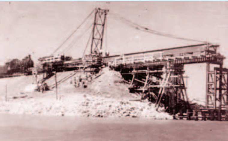
Апрель 1944 года: начало строительства моста через Керченский пролив. На снимке изображен момент установки первого металлического пролета краном-пилоном на западном берегу
