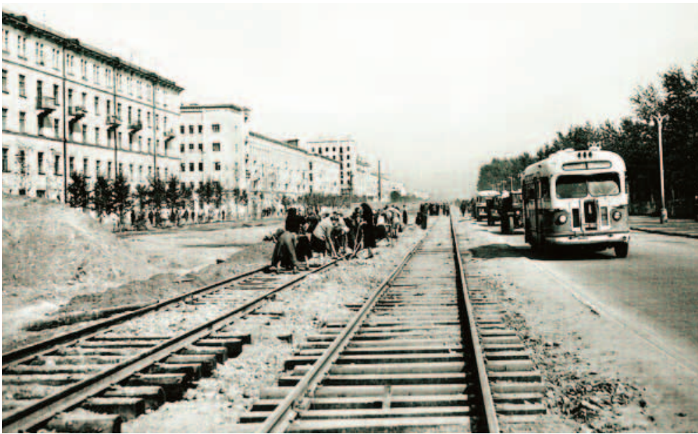
Прокладка трамвайных путей на проспекте Красноярский рабочий. 1957г.
