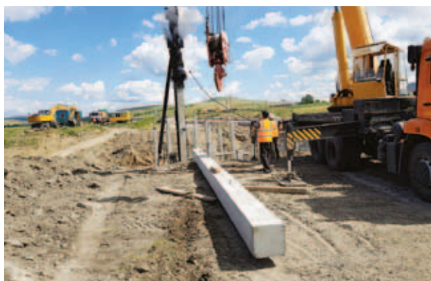
Стройка моста через р. Теплый Ключ, Краснотуранский район
